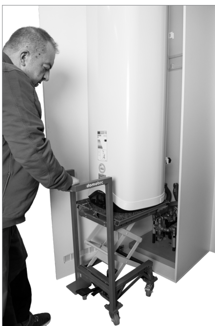
Abb.: Installazione con Domolift
