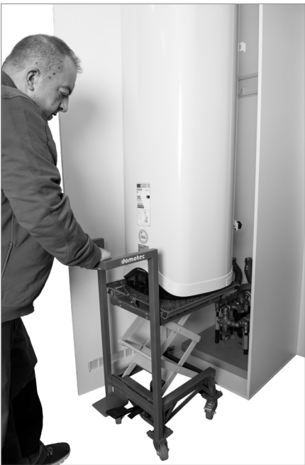
III. : Montage avec Domolift
